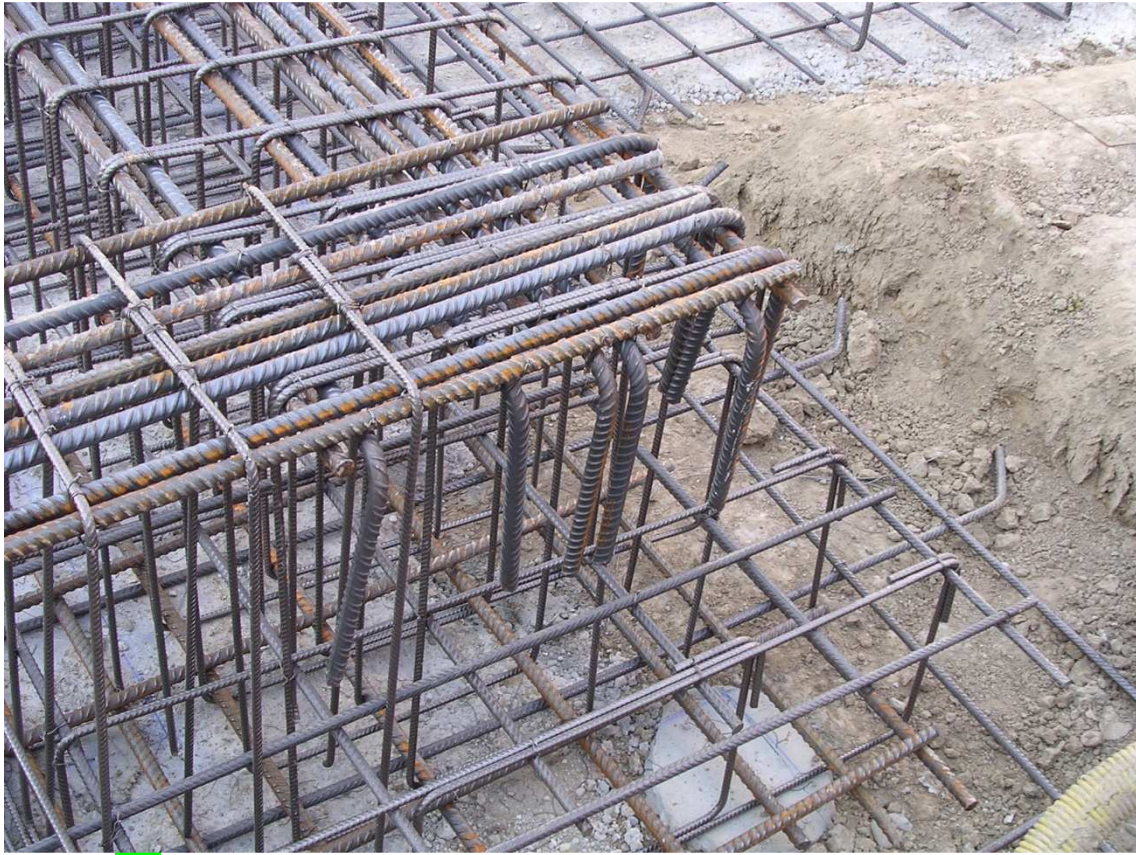
(14) SI – Ancoraggio ferri con spezzoni di sovrapposizione con squadro (accettabile, ma si ha un notevole fittume di ferri )
