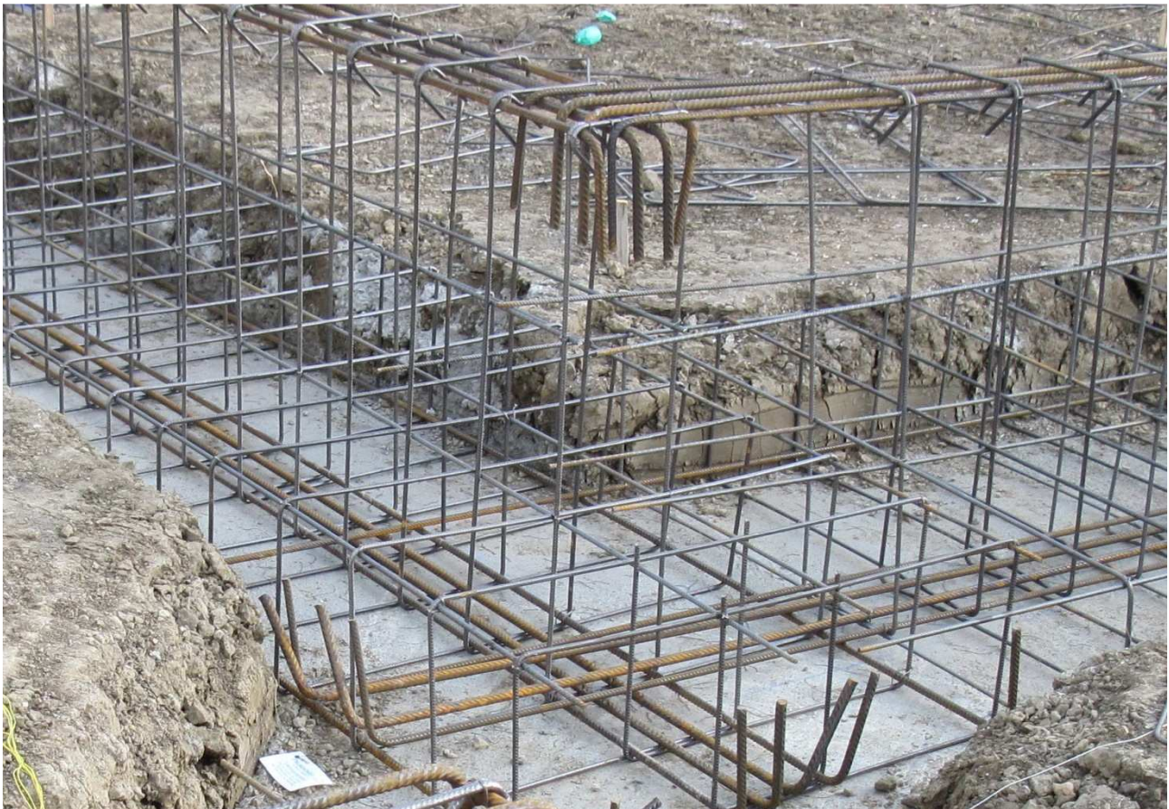
(15) SI – Ancoraggio ferri con barre risvoltate alle estremità ( decisamente preferibile)
