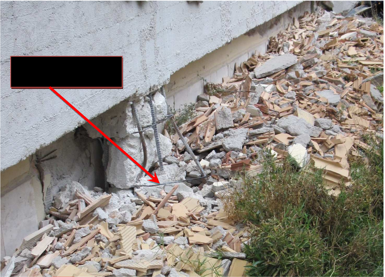
(20) NO – Le staffe ( \Phi 6 ) a passo largo (25 cm) con gancio a 90^\circ e non anti-sismico sono aperte e raddrizzate e tutti i pilastri del piano terra sono scoppiati ...
