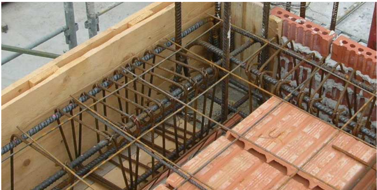
(23) SI – Il passo delle staffe è stato raffittito in corrispondenza del pilastro ( mancano però ancora le staffe del pilastro nel nodo)
