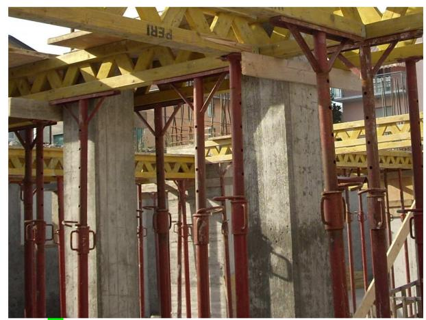
(34) SI – Durante la fase di casseratura sono stati impiegati gli smussi rompi spigoli: i pilastri disarmati sono perfettamente integri.
