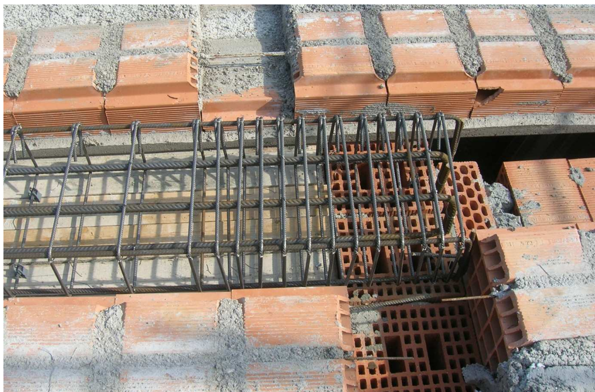
(39) SI – La gabbia della trave ha un ottimo appoggio sulla muratura .
