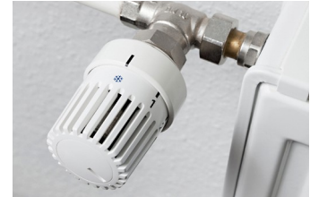
Installazione valvole termostatiche
