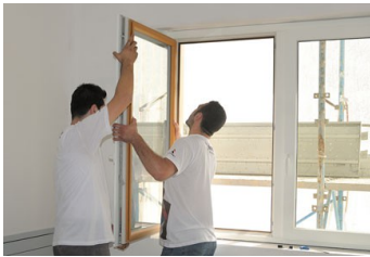
Sostituzione serramenti esterni
